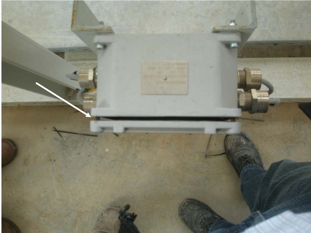
Φωτογραφία 1: Στη φωτογραφία αυτή, φαίνεται ότι σε έναν ολοκαίνουργιο ηλεκτρολογικό πίνακα, κατά τη διαδικασία έναρξης λειτουργίας (commissioning) της εγκατάστασης, η μη διεξαγωγή του αρχικού ελέγχου (Initial Inspection) ακυρώνει την προστασία του εξοπλισμού, λόγω του διάκενου που έχει αφεθεί ανοικτό (βέλος).
