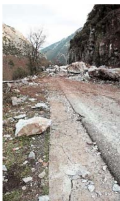
Από το καταστροφικό ατύχημα στα Τέμπη με την απώλεια γνωστού ιταλού συναδέλφου Μηχανικού (φωτό in.gr).
